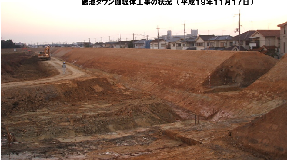
鶴池タウン側堤体工事の状況（平成19年11月17日）
