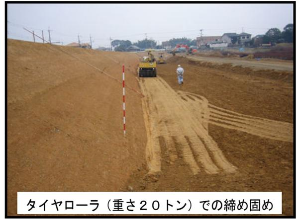
タイヤローラ（重さ20トン）での締め固め
